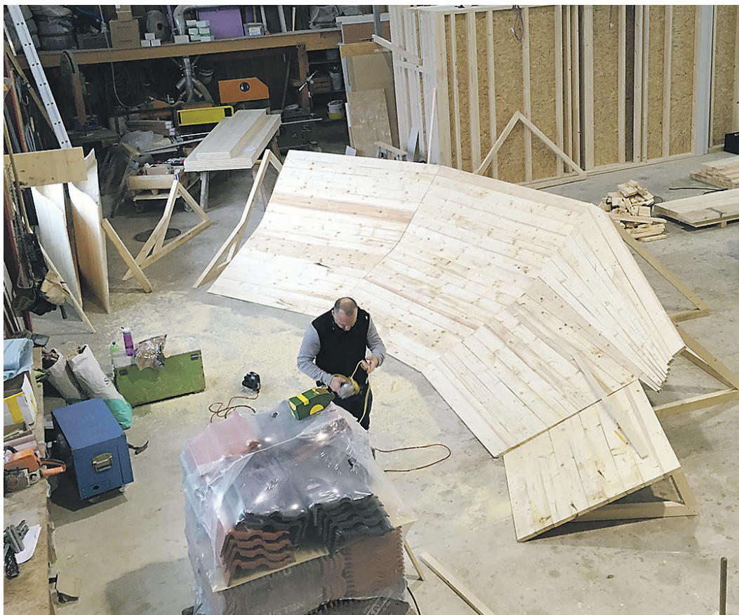
Unter fachkundiger Anleitung der Glarner Firma Trailworks wurde die Steilwandkurve für die neue und attraktive Kids-Race-Strecke von Thomas Uhr, Stefan Oechslin und Michael Gerold in der Holzbauhalle von Beda Kälin in Egg gleich selber hergestellt.
